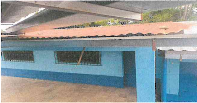
Foto 1: Sustrucción de lamina acanalada por lamina troquelada
