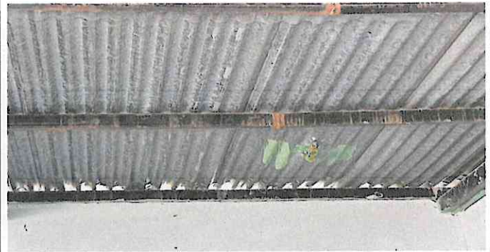
Foto 2: Sustrucción de lamina acanalada por lamina troquelada
