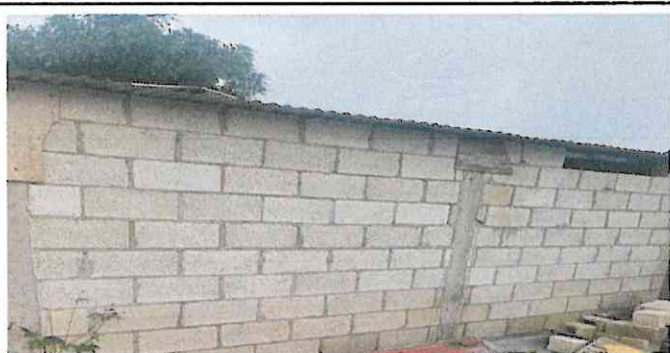
Foto 5: cernido de paredes
