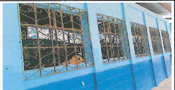
Foto 6: mantenimiento de balcones
